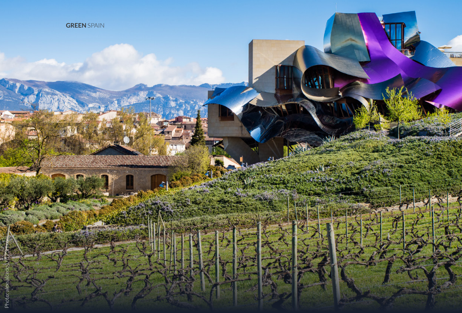
▲ MARQUÉS DE RISCAL WINE-CELLARS ELCIEGO, ÁLAVA
